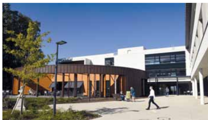
Hôpital Andrevetan à La Roche-sur-Foron (74) [ construction ]
